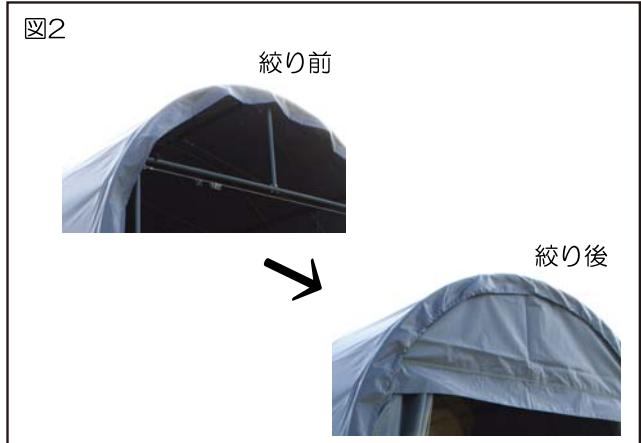
メインシート出入口アーチ下部に付属している平ヒモを出入口シート下部にあるハトメ穴とドアベースパイプの丸型のステーに通しドアベースパイプに付属しているラチェットに通します。
